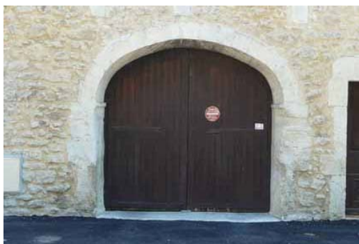
Porte de garage simple, en bois peint qui s'inscrit correctement dans l'ouverture existante (une ancienne porte de grange).
