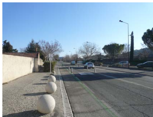
Des trottoirs confortables et continus, des cheminements en site propre pour les vélos, des revêtements de sols de qualité, limitant l'enrobé à la bande de roulement, des plantations structurantes peuvent atténuer le côté routier de ces avenues et apaiser les espaces.
