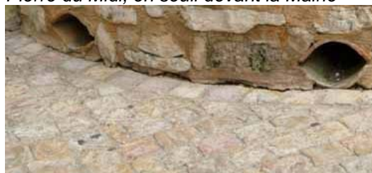
Détail du calepinage en pied de mur, Saint Paul
