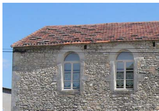
Fenêtres cintrées, le vitrage suit la courbure de l'ouverture.
