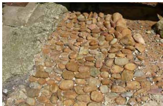
Reste de calade devant hôtel Narbonne Pellet. Ce mode de revêtement devait recouvrir l'ensemble des rues du centre historique.
