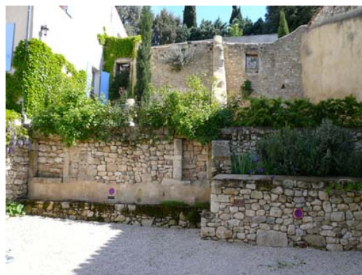
Démolition sans reconstruction rue de la Pousterle. Création de stationnement, traitement intéressant de l'espace et des façades visibles.
