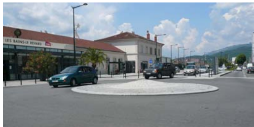
Carrefour giratoire « urbain » à Aix-les-Bains : assez plat, dallé de pierres, sans décor ni panneaux de signalisation.
