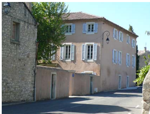
Les façades de l'habitation sont enduites.
