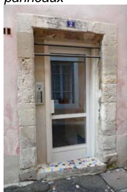
Eviter : l'ouverture XVII e s réduite pour placer une porte standard
