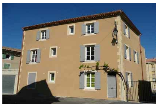
Cours de Valaurie. Les réseaux sont bien intégrés sur cette façade
