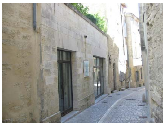
Uzès (Gard). L'espace dégagé et la sobriété du traitement de l'espace public révèlent la qualité des façades.
