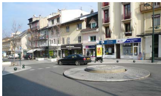
Carrefour giratoire « urbain » à Aix-les-Bains : relativement plat, dallé de pierres, sans décor ni panneaux de signalisation.
