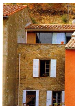
Ce type de terrasse pourrait être autorisé pour des parcelles peu profondes dont la largeur de façade est inférieure à 5m.
