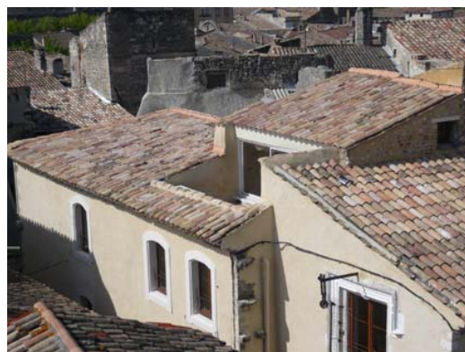
Terrasse en toiture, exemple intéressant
