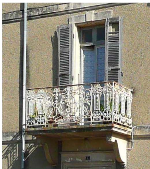
La finesse et la « transparence » du garde-corps contribue à la qualité de cette façade.
