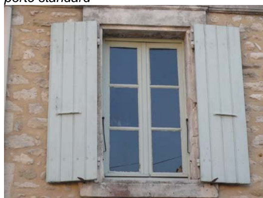
La partition du vitrage varie selon l'époque du bâtiment et la hauteur des niveaux. Elle peut être de 4, 6 ou 8 carreaux par fenêtre.
