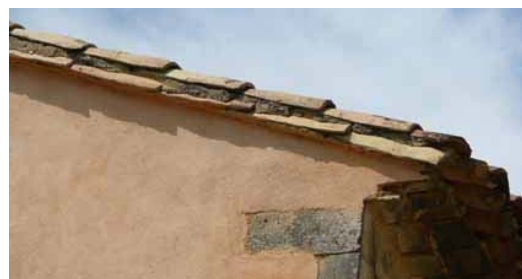
Tuiles canal : rives traditionnelles à deux tuiles scellées
