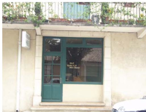
Vitrine correctement positionnée à l'intérieur des ouvertures.
