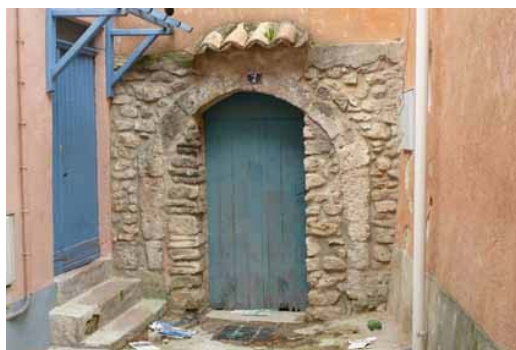
Le retrécissement de l'ouverture est interdit
