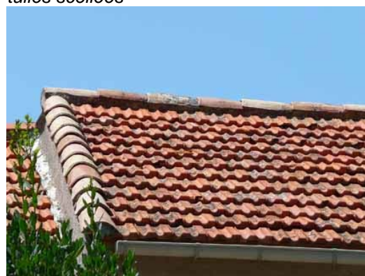
Tuiles mécaniques : exemple de traitement du faîtage et de la rive avec de simples tuiles canal.
