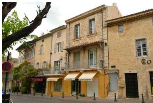
La verticalité des façades est contrariée par la teinte jaune au RDC des deux façades
