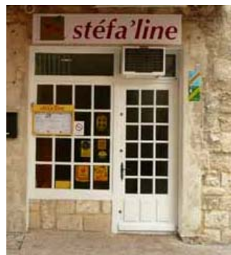
climatiseur : pose interdite
