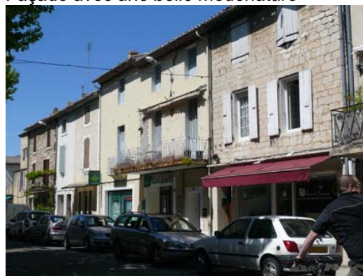
Façades dans les murs du rempart, donnant sur le Courreau
