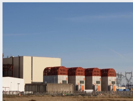
Diesels d'Ultime Secours (DUS) de 3 MWe
